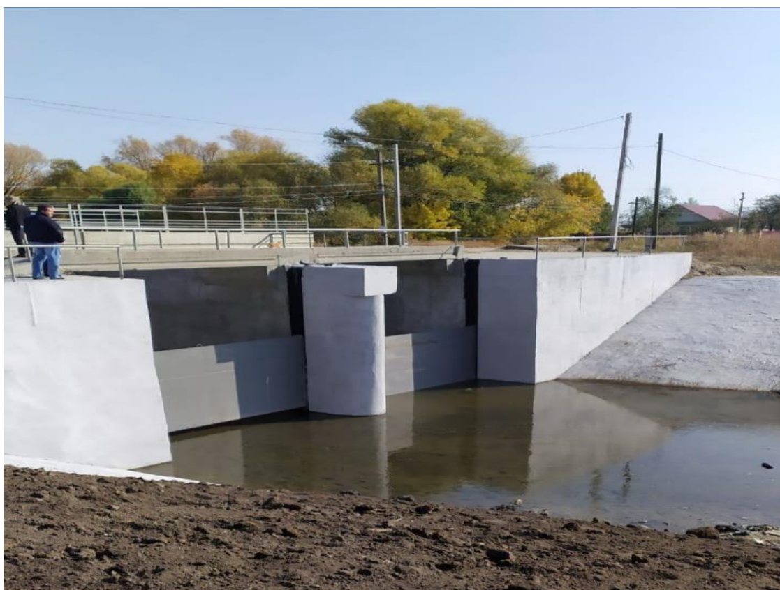
Фото № 3. Капитальный ремонт русловой плотины на р. Машня в р.п. Земетчино Земетчинского района Пензенской области
