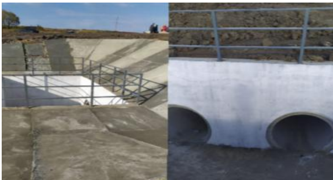
Фото № 2. Капитальный ремонт узла гидротехнических сооружений пруда «Гольцовский» в р.п. Лунино Лунинского района Пензенской области
