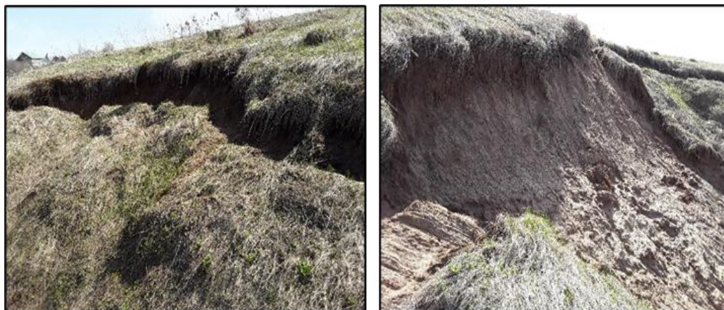
Фото № 8. Активизация оползневого процесса на склоне оврага Южный и его отвержках
