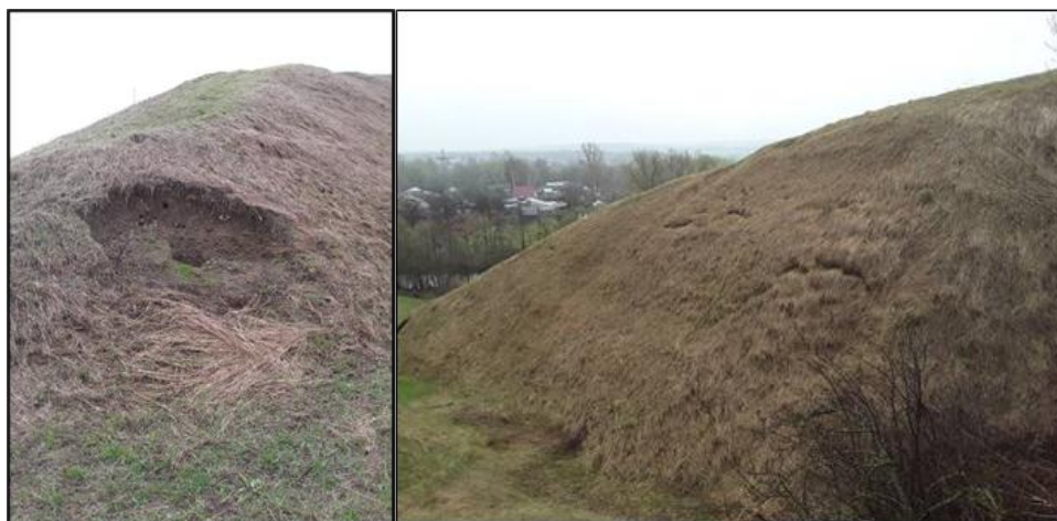
Фото № 11. Оползневой цирк. Трещина формирования оползневого цирка
