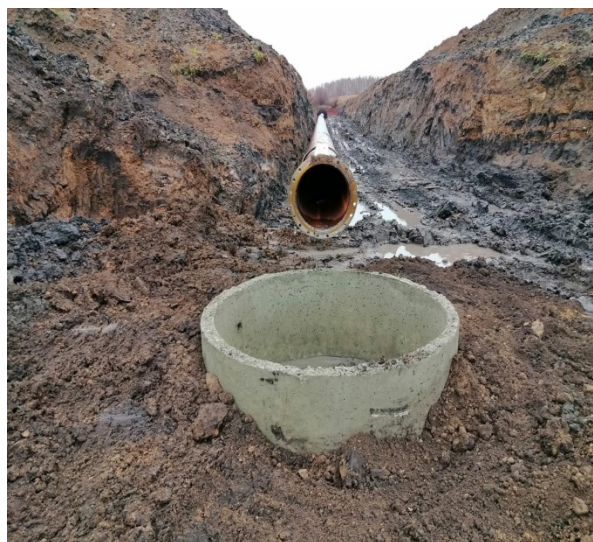
Фото № 2. Ход проведения ремонтных работ
